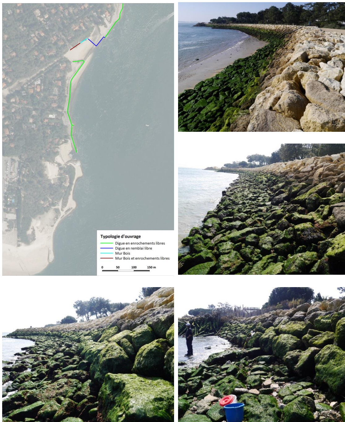
Figure 43. Ouvrages entre Hortense et la Pointe (source : GEOLITHE, 2016).
