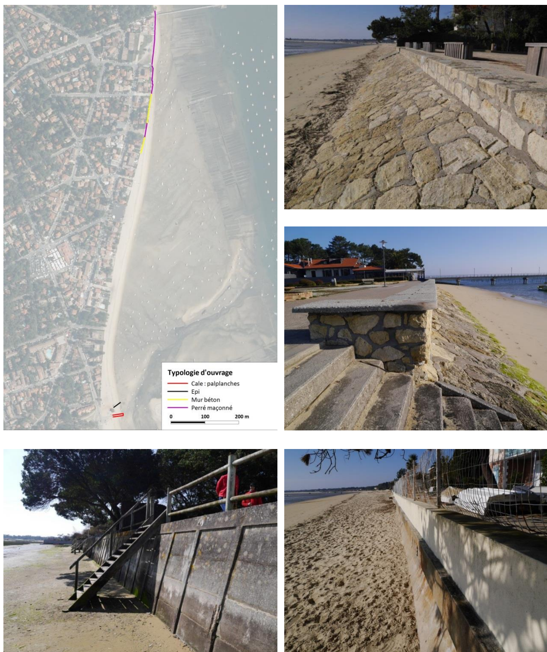
Figure 56. Perrés maçonnés et murs verticaux sur le secteur de Bélisaire (source : GEOLITHE, 2016).
