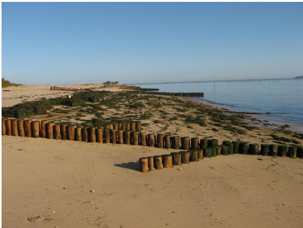
Figure 53. Épis en bois de l'enracinement de la flèche du Mimbeau (source : ARTELIA, 2008).
