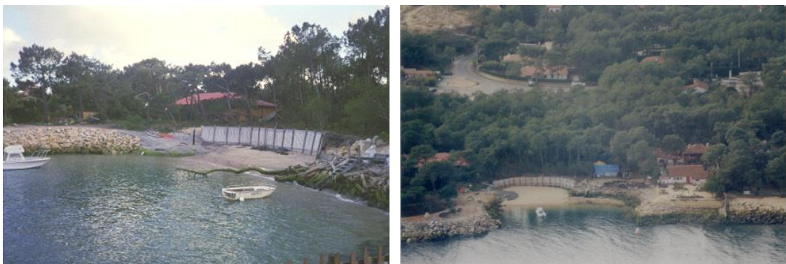
Figure 45. Photographies de l'effondrement du 27 décembre 2000 au droit de la propriété de M. Bez (source : SOGREAH, 2003).
