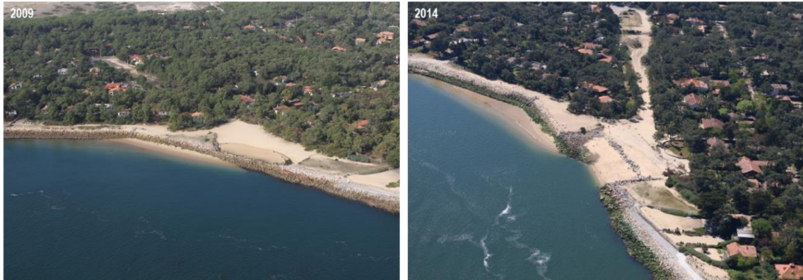
Figure 46. Photographies de l'effondrement du 01 février 2014 au droit de l'allée du Tram (source : Michel Le Collen (gauche) ; Olivier Chaldebas (droite)).
