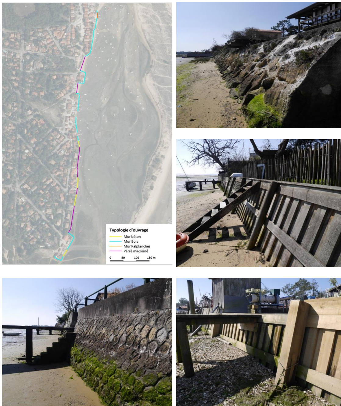
Figure 55. Perrés maçonnés et murs sur le secteur de la conche du Mimbeau (source : GEOLITHE, 2016).
