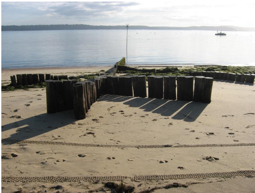
Figure 54. Épi en bois de l'enracinement de la flèche du Mimbeau (source : ARTELIA, 2008).
