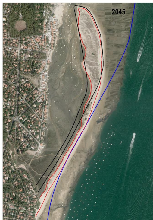
Figure 30. Évolution de la flèche du Mimbeau. rouge : trait de côte 2014 ; noir : trait de côte 2045 ; bleu : Limite estran/petits fonds 2045 (source : ARTELIA/GEOTRANSFERT, 2015).
