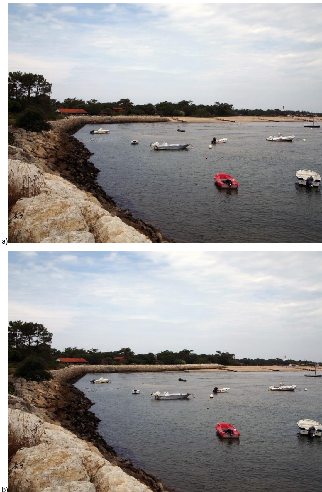
Figure 61 : Visualisation de l'enracinement de la flèche du Mimbeau pour le scénario 3 : a) en 2016 – b) Après allongement de la protection en enrochements de haut de plage.
