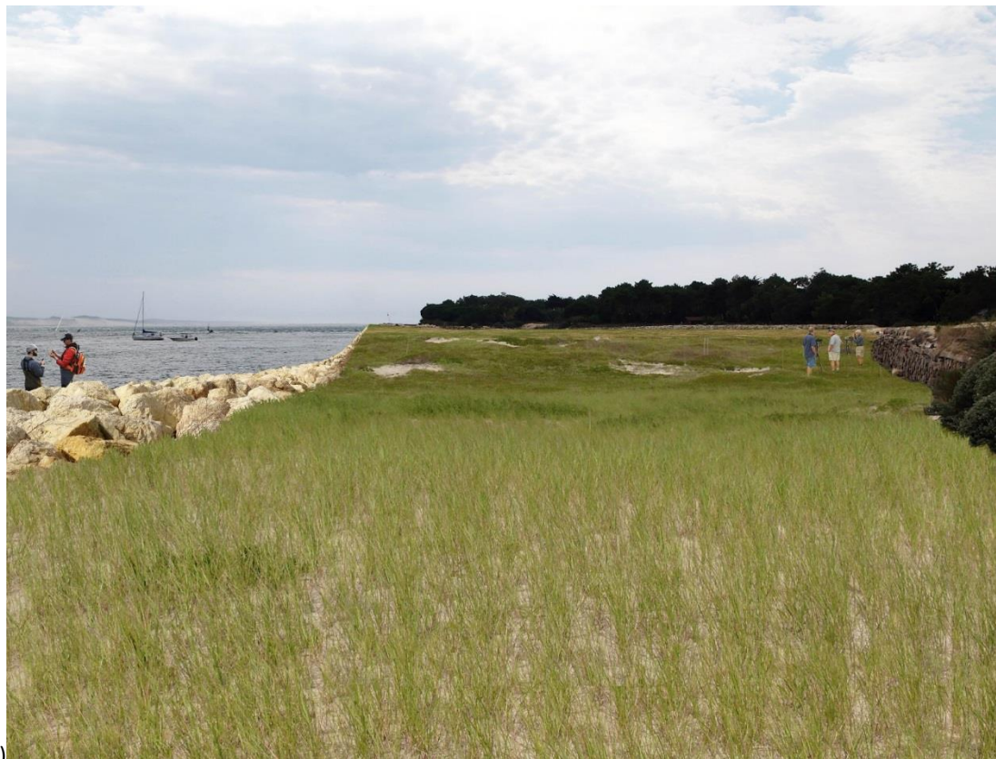
Figure 42 : Visualisation de la protection de première ligne du secteur des 44 ha : a) ouvrage actuel en 2015 – b) Construction d'une nouvelle digue + remblai végétalisé selon le scénario 3c.
