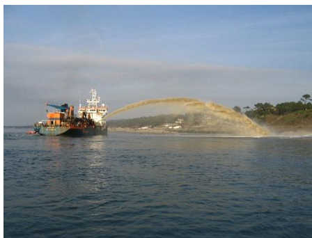
Figure 57 : Technique de rechargement par « rainbowing » sur les plages pilataises.
