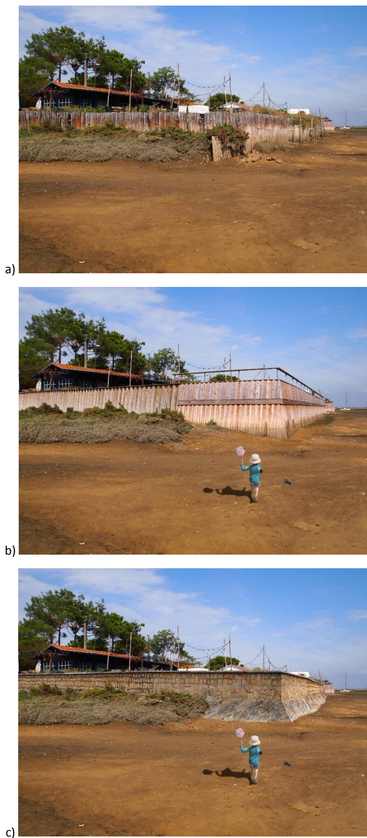
Figure 75 : Visualisation du devenir d'un ouvrage de la conche du Mimbeau selon le scénario 3 : a) en 2016 – b) Après réflexion sur une structure de type bois -c) Après réflexion sur une structure de type maçonnée.
