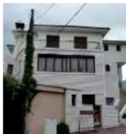
Construction en R+2
