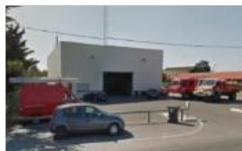
La caserne de pompiers au Cap Ferret
