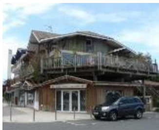
Construction implantée à l'alignement : commerces en RDC et logements à l'étage
