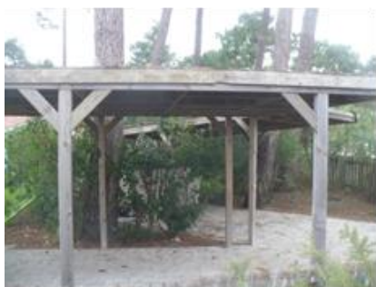
Intégration d'un abri à voiture entre les pins à Petit Piquey
