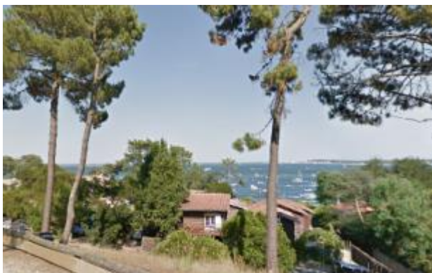
Construction sur la dune bordière du bassin et panorama
