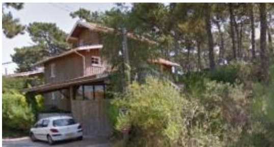
Construction implantée au flan de la dune boisée
