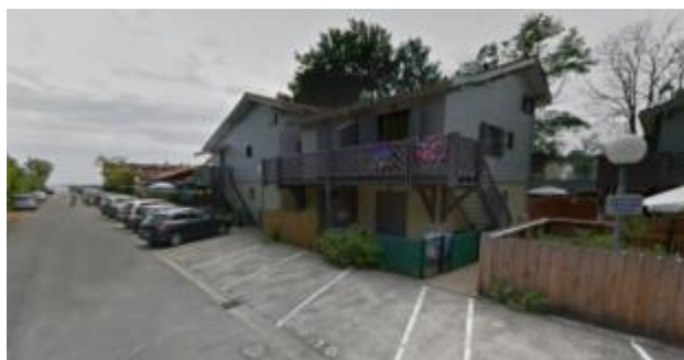
Petit Piquey – Nouveaux bâtis de logements intermédiaires issus de démolition reconstruction – Amorce de diversification du parc bâti.
