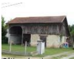
Bâti rural ancien
