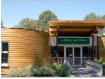
Centre multi-accueil à Claouey
