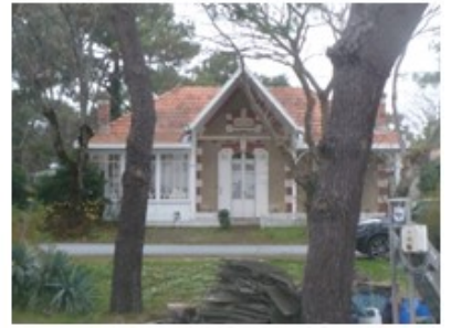
Villas située au contact du village de l'Escourre de la Douane
