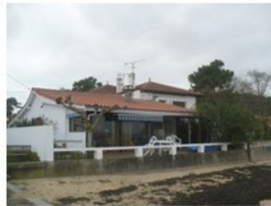
Maison construite sur le haut de la plage au Jacquets
